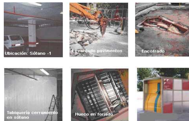
Imagen 62. Secuencia de fotos de obra civil para instalar un biceberg en un garaje. Fuente: www.biceberg.es
