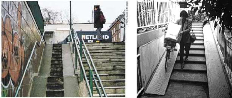
Imagen 52. Rampas en escaleras para bicicletas 11 .
